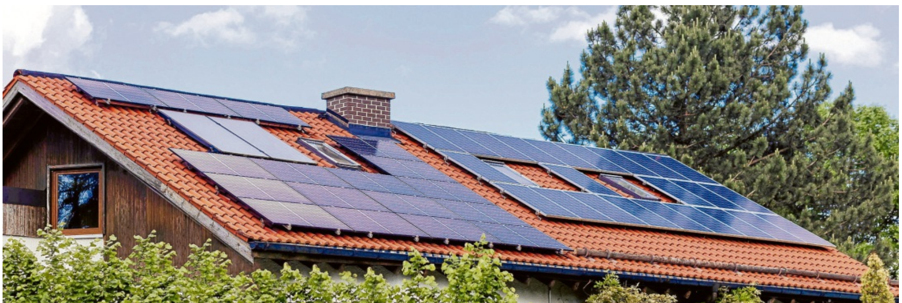
Die 50.000. EEG-Anlage wurde im Oktober 2025 im Netze ODR-Gebiet installiert und ans Netz gebracht.
