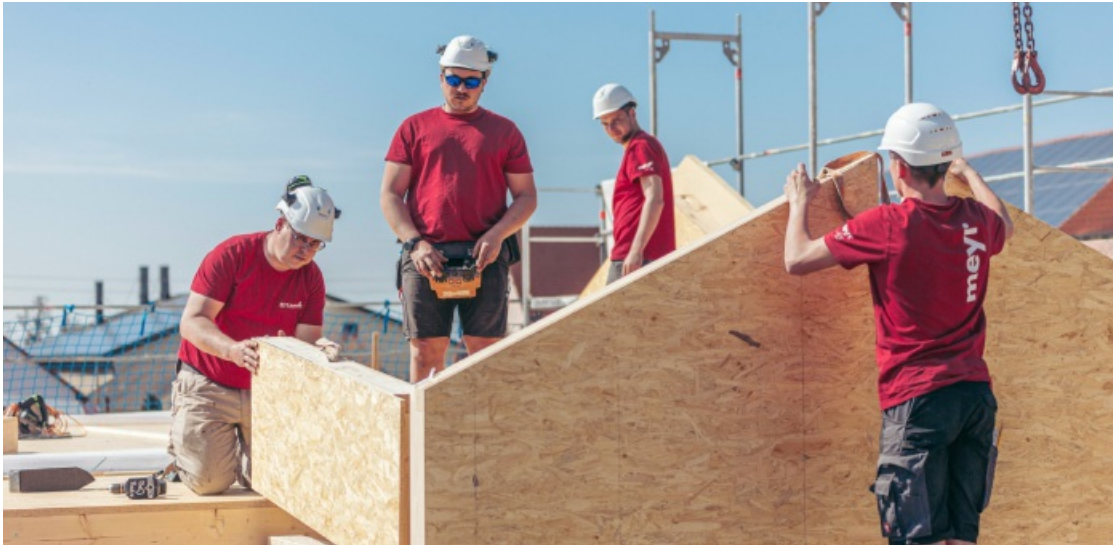
Fachkräfte der Firma Meyr auf der Baustelle bei der Montage eines Holzhauses.
